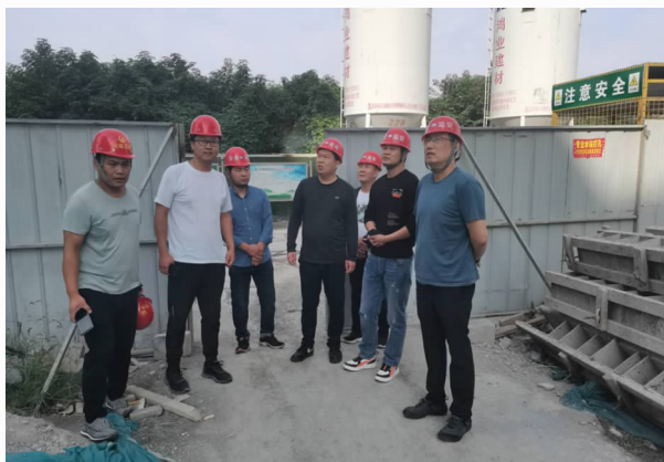
9 月 28 日，区住建局尹飞局长带队到鼎泰一号院建筑施工工地施工现场进行安全监督检查
