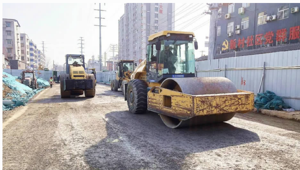
劳动路贯通工程顺利开工 区交通局供图
