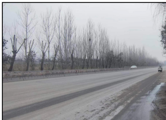
西侧西外环路
