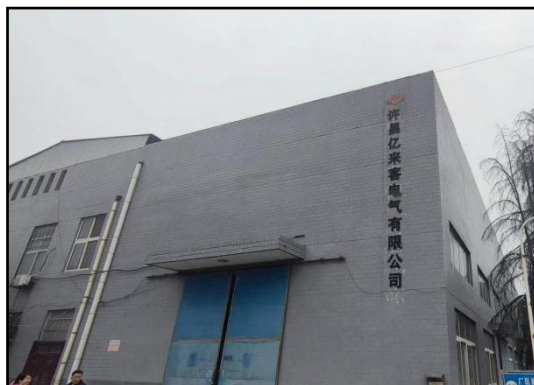
扩建项目车间
