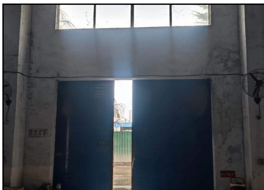
车间内部现状
