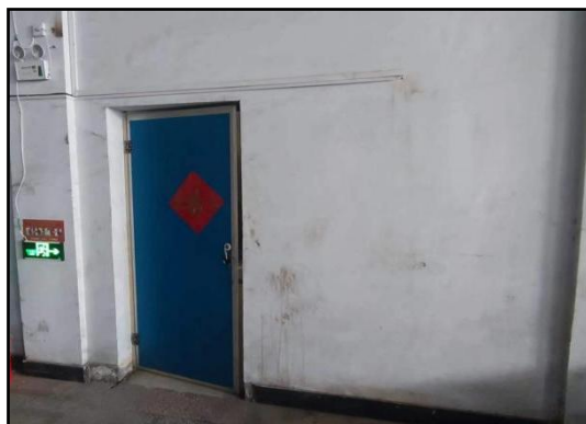
车间内部现状
