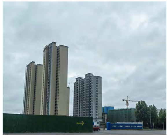
项目西侧施工的万象小区
