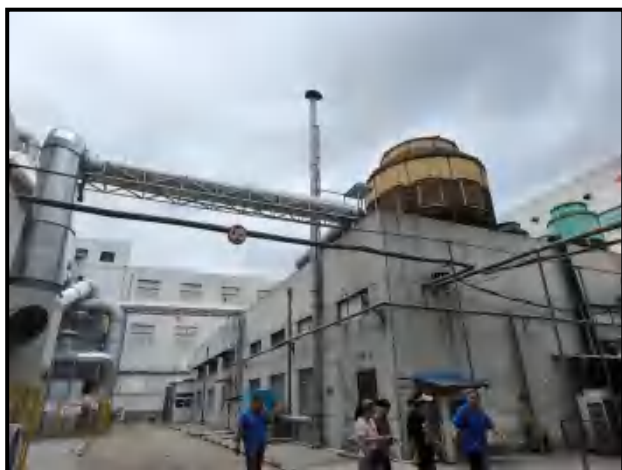
现有工程-除尘器+16m 排气筒
