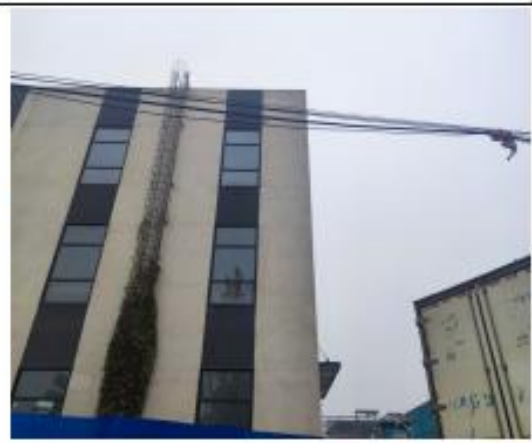
北侧在建环保科技产业园
