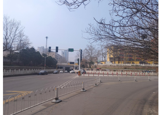
新兴路穿越京广铁路现状
