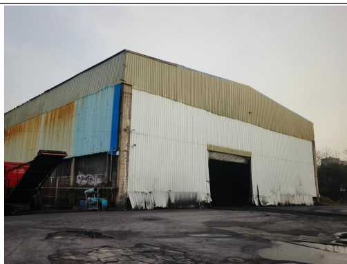
化水车间现状
