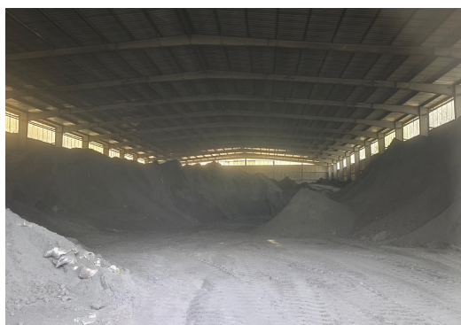
锅炉房位置现状煤棚
