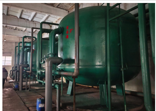
化水车间内部现状
