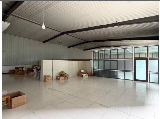
项目车间现状
