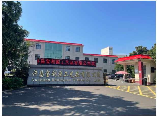
项目南侧-隔金黄大道为许昌宝利源工艺品有限公司
