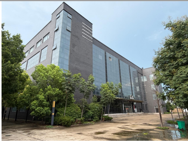
项目西侧-餐厅（河南瑞美真发股份有限公司）
